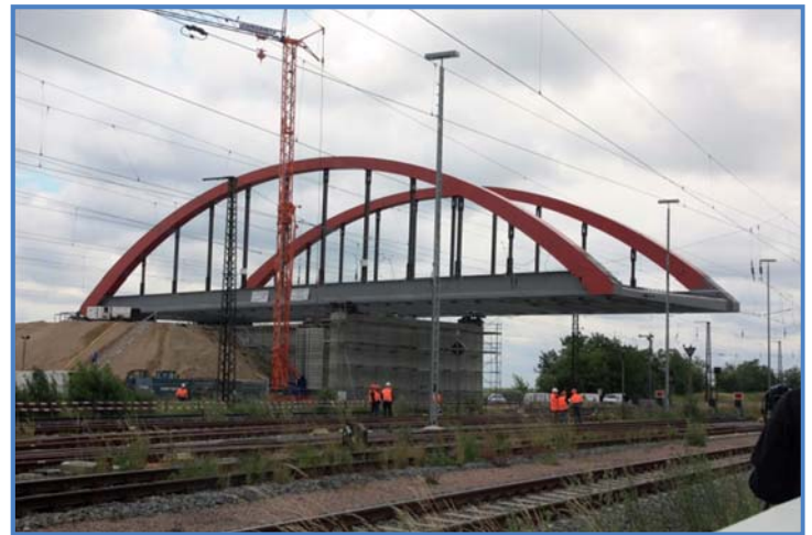
Brückenbau zur Bundesstraße B6n – Ende Juni 2013 Einschub der Brücke über die Eisenbahnstrecke Richtung Dessau und Leipzig
