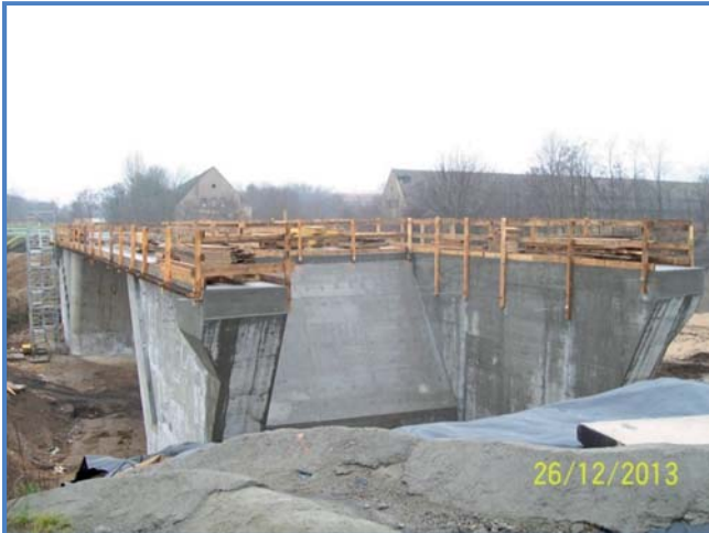
Brückenbau zur Bundesstraße B6n Brücke über die Baasdorfer Straße – Dezember 2013
